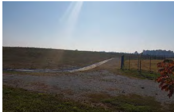
Slika 3. Sanirana površina odlagališta s obodnim kanalom i požarnim pojansom
