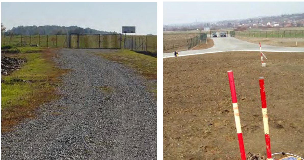
Slika 1. Pristupna ulazna cesta do odlagališta Rešetari (pogled s vanjske i unutrašnje strane odlagališnog prostora)
