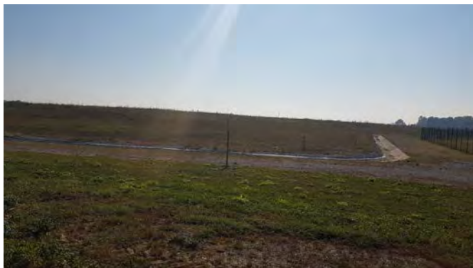
Slika 3. Sanirana površina odlagališta s obodnim kanalom i požarnim pojansom
